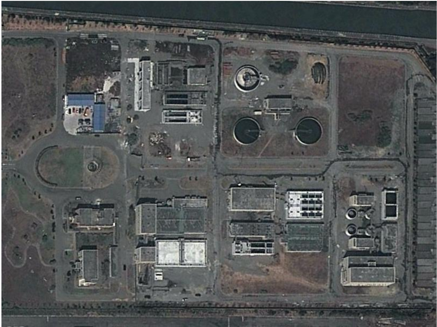
線西廢水處理廠空照圖(擷取至google map)
