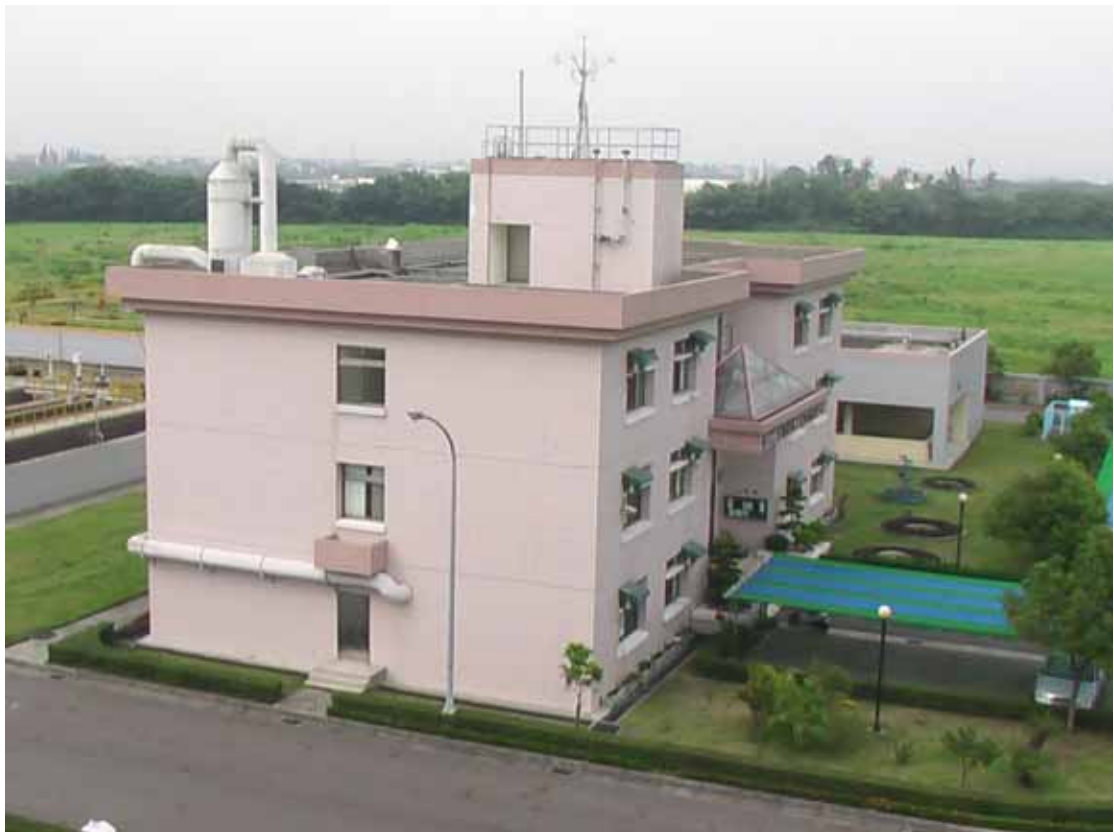
雲科污水廠操作大樓
